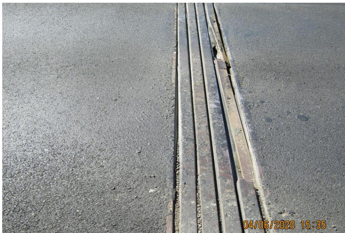
Фотоизображение деформаций и разрушения деформационного шва автодорожного моста (фотография автора – Д. В. Демидова)
